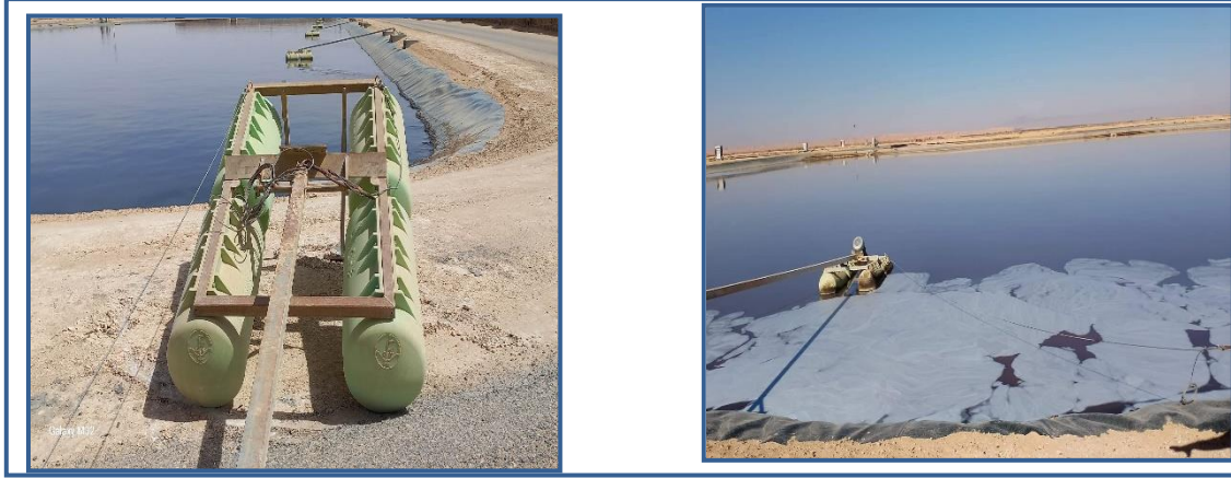
الشكل 6.III: الأحواض المهواة
