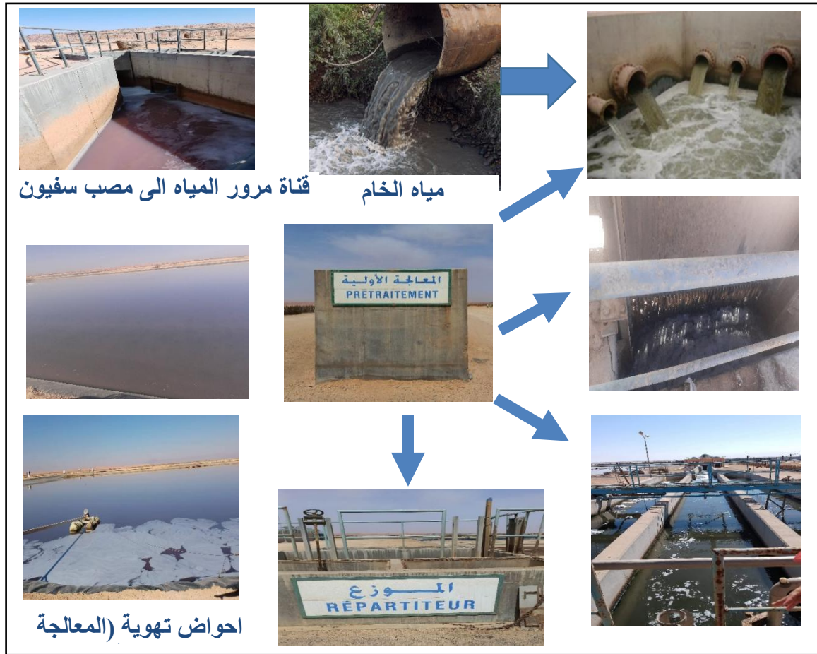
الشكل III.9: مراحل المعالجة على مستوى المحطة
