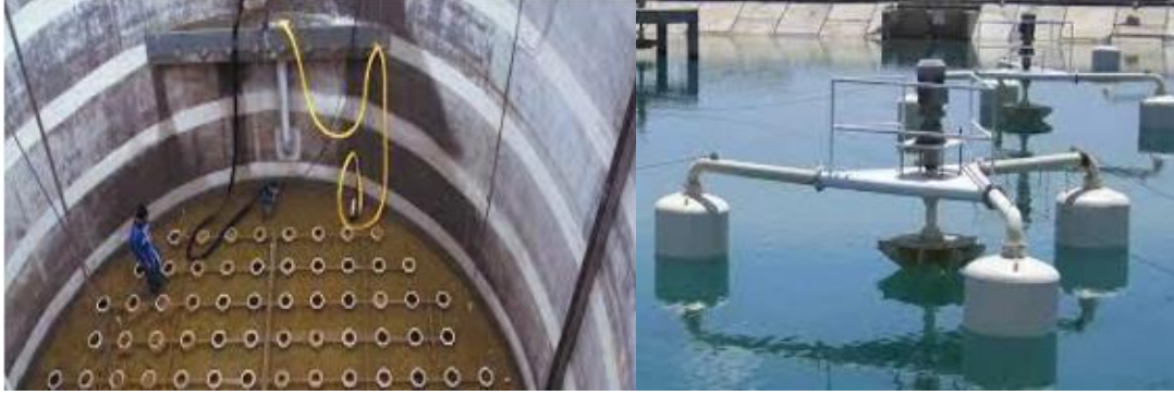
الشكل 11.II:جهاز تهوية السطح الشكل 12.II:جهاز التهوية عن طريق النفخ في الهواء
