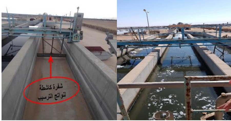
الشكل 5.III: جهاز إزالة الرمل
