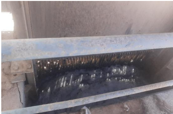
الشكل 4.III: مرحلة نزع المواد الصلبة الكبيرة
