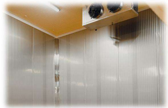
Figure I.13 : Déshumidificateurs dans les chambres froides
