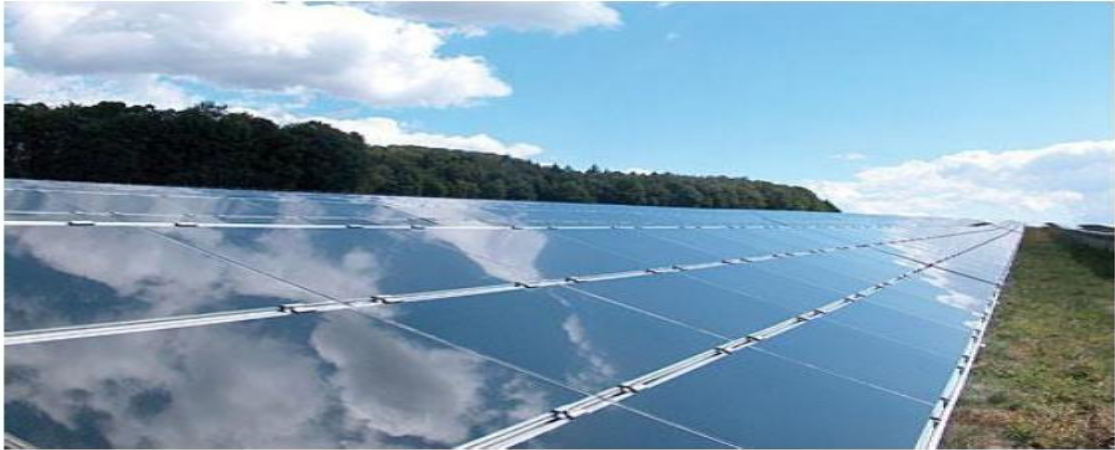
Figure. I. 12 : modules verre-verre au Telluride de Cadmium, efficacité de 9 11%.
