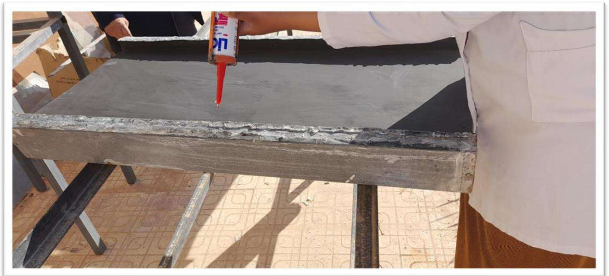
Figure. II.12 : Mettre de la silicone pour éviter les fuites.
