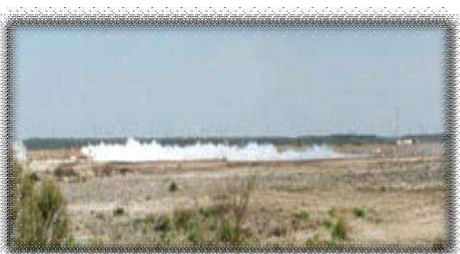
Fig– 5 relâchements d'ammoniac suite à une rupture de canalisation
