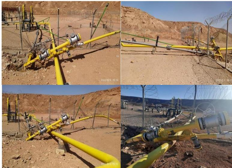
**Figure. III. 02 : Présentation de L'explosion de l'installation de surface**
