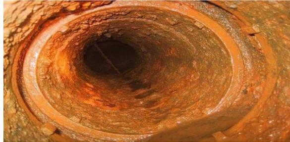
**Figure. III. 09 : Corrosion Interne**
