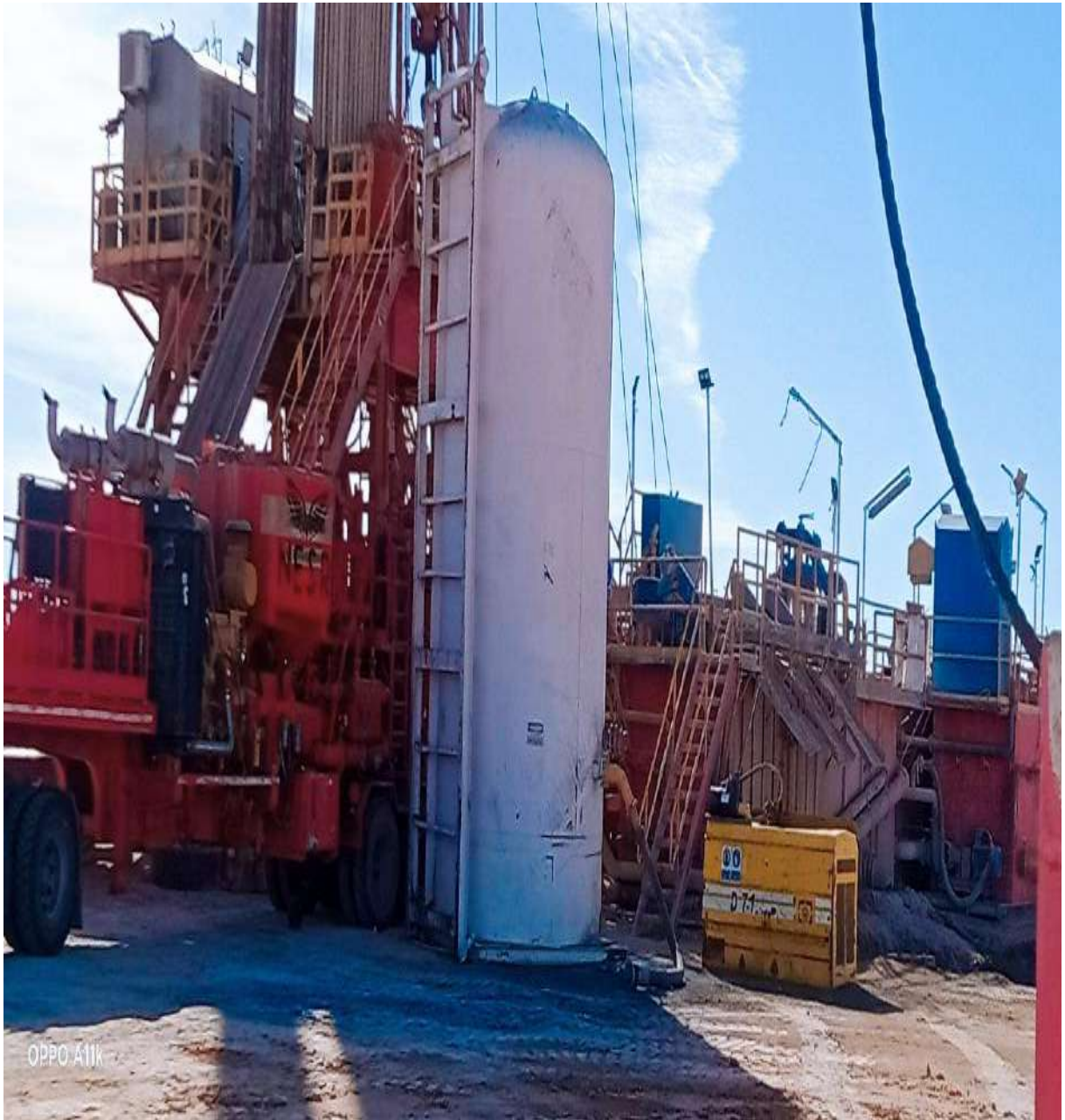
Figure IV-05 : Pompage ciment dans le puits.
