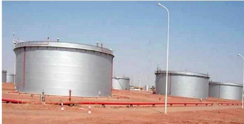
*Figure1 : Réservoirs à toit flottant [2]*
