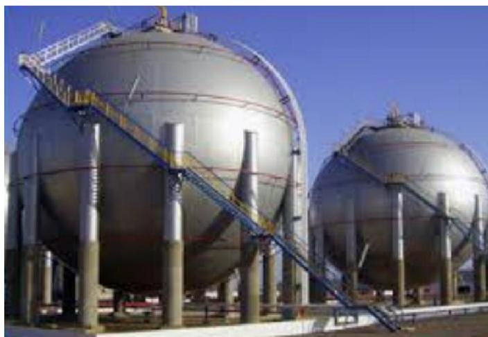
*Figure 4 : Réservoir sphérique [2]*
