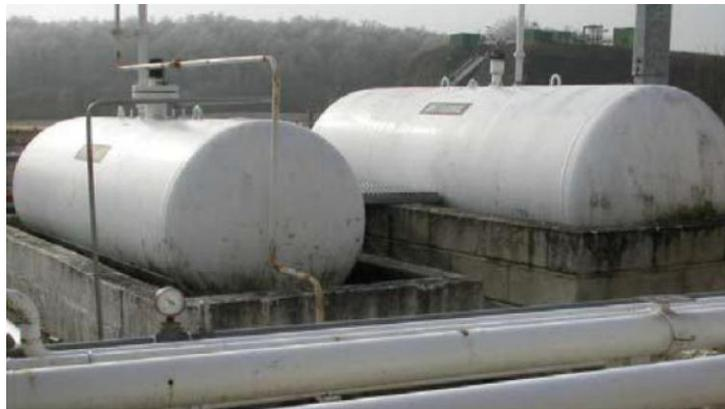
*Figure 5 : Réservoirs horizontaux [3]*
