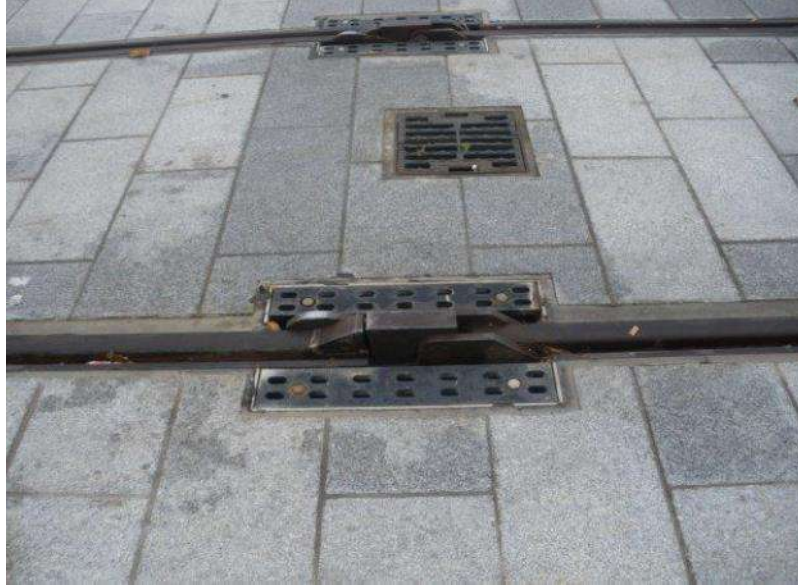
Figure III.4 : Taquet d'arrêt d'un tramway [31].
