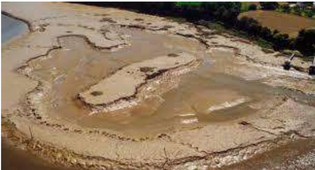
Figure1. 6 : envasement d'un barrage par l'érosion hydrique
