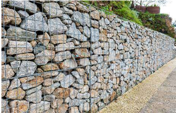
Figure 1.8 les murs de soutènement
