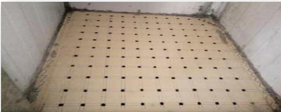
**Figure II.7:** Plaque perforée en polycarbonate
