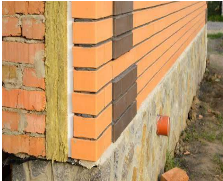
Figure I.1: Panneaux d'isolation thermique entre deux murs.
