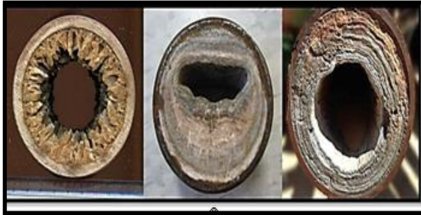
Figure I.1: dépôt de Sulfate de baryum sur les pipe.[6]
