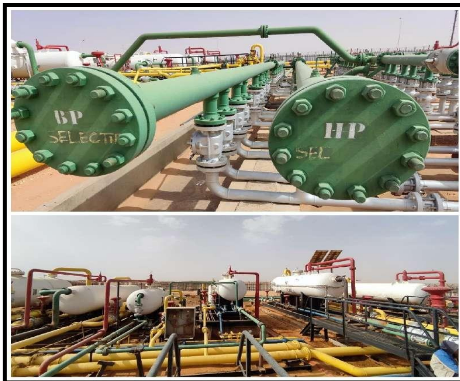
Figure II.16 : La séparation sélective au niveau de CS1
