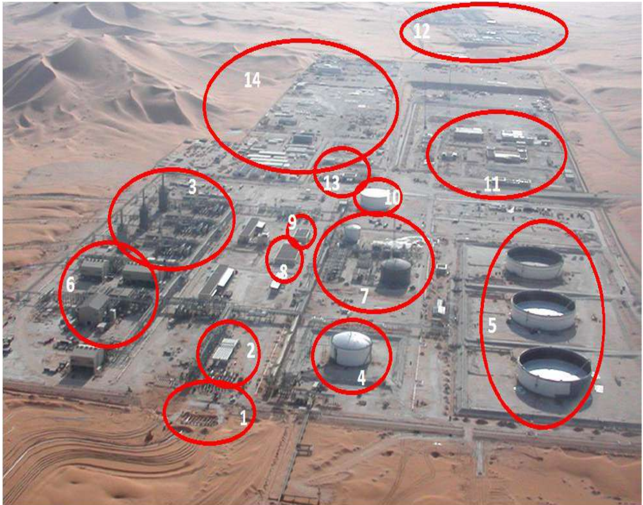
Fig. (I.5): vue aérienne du site de production et la base de vie [2].
