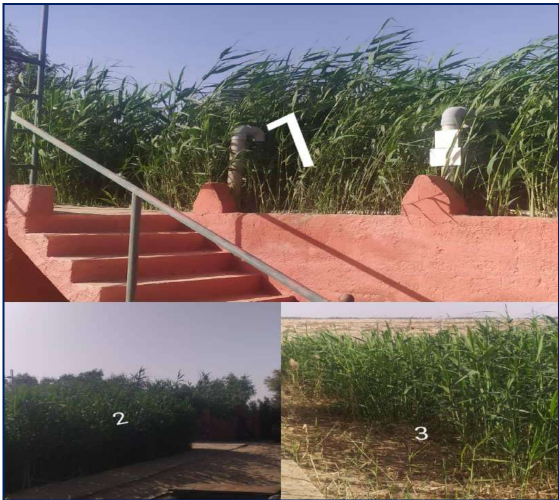
Figure III. 5 : Les trois bassins de filtration à anches installés verticalement
