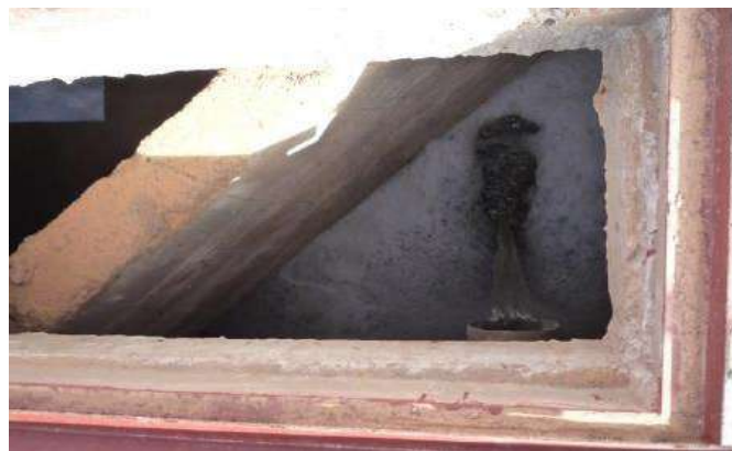
Figure III.4 : Bassin de déshuilage.
