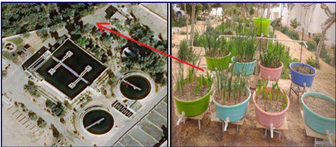
Figure III.5 | Photo de la mise en place du pilote expérimental à écoulement hybride (HCW).
