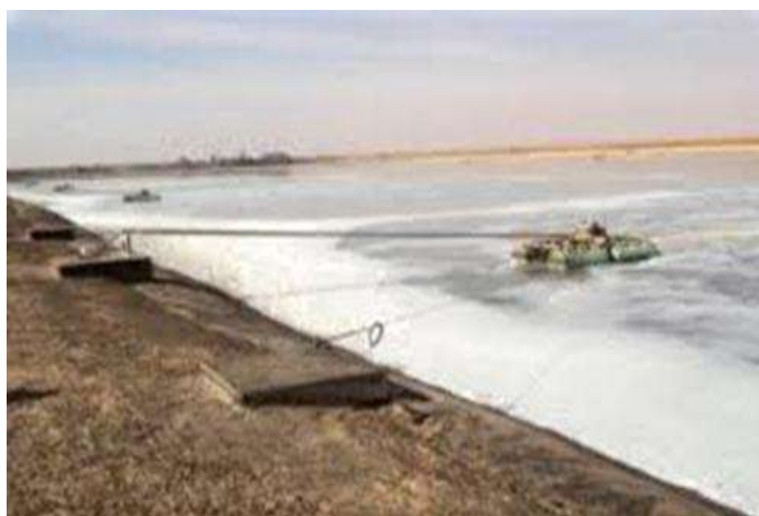
Figure 56. Lagune d'aération. STEP de Ouargla
