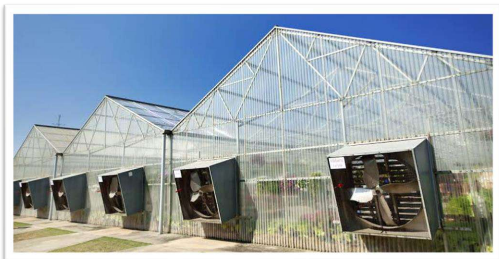
Figure I.11: Exemple de la ventilation forcée.
