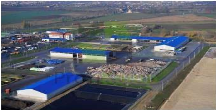
Figure 2.8 : Photo d'une décharge contrôlée
