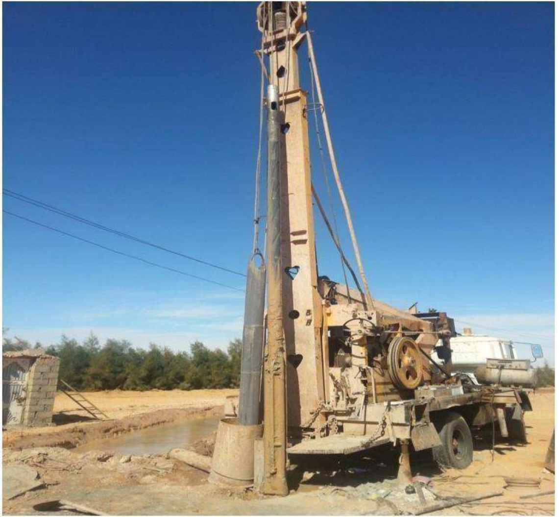
Figure 12 : La machine de forage de puits (le marteau-piqueur) [09]
