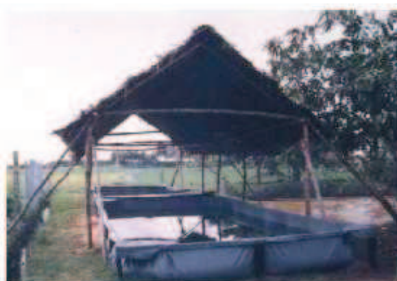
Photo.8 : Un bassin en tissu polyamide enduit PVC Eco Park, Madurai, Tamil Nadu (Inde) 18 m 2 , 1998
