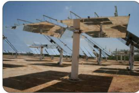
Figure 1.5 : Héliostat à type T avec position de rabatement complète.
