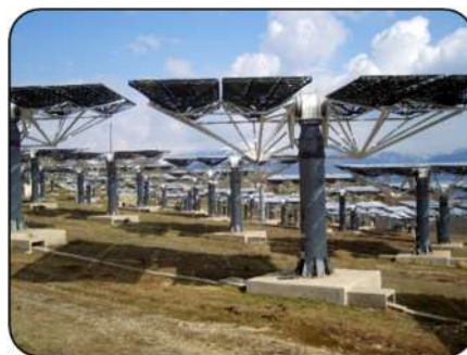
Figure 1.11 : Fondation en béton d'héliostat de la centrale solaire de THEMIS .
