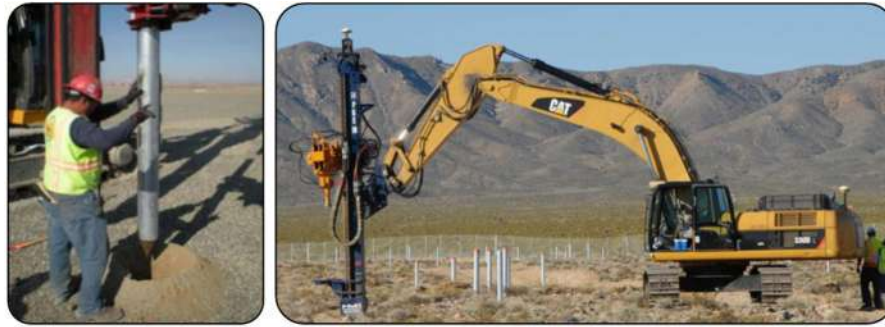
Figure 1.12 : Fondation avec insertion du pylône à Ivanpah Solar.
