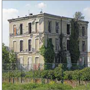
Figure I.4: Maison de F. COIGNET à Saint Denis (France).
