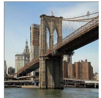
Figure I.7: Pont de Brooklyn à New York (Etats-Unis).
