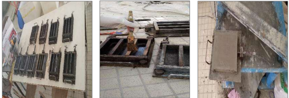
Photo II.19: La mise en place de béton.
