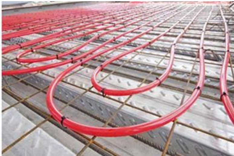
Figure II. 7:Dalle Actif : In-situ.
