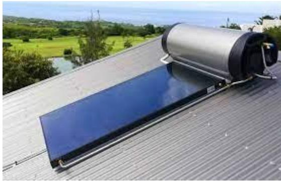
**Figure I. 6: chauffe-eau solaire monobloc[14]**
