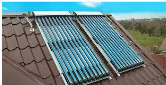
**Figure I. 11:les capteurs a tube sous vide placé sur le toit[25]**
