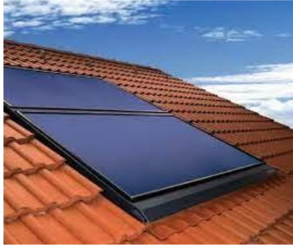
**Figure I. 10:capteur plan vitré placé sur le toit[23]**
