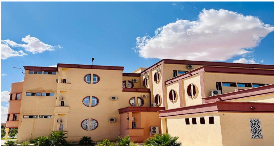
Fig.1.1. Façade Nord comportant un nombre important de climatiseurs.
