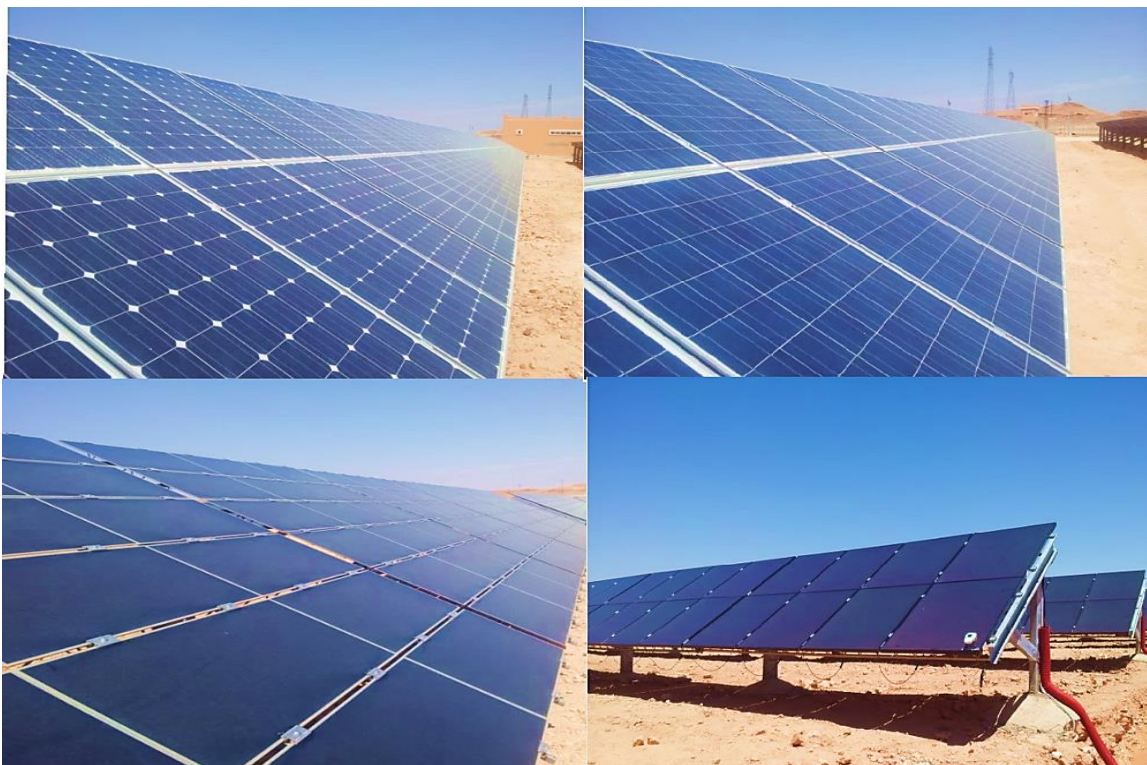
Figure I. 29 : les quatre types des panneaux photovoltaïques existants en centrale d'Oued Nechou Ghardaïa
