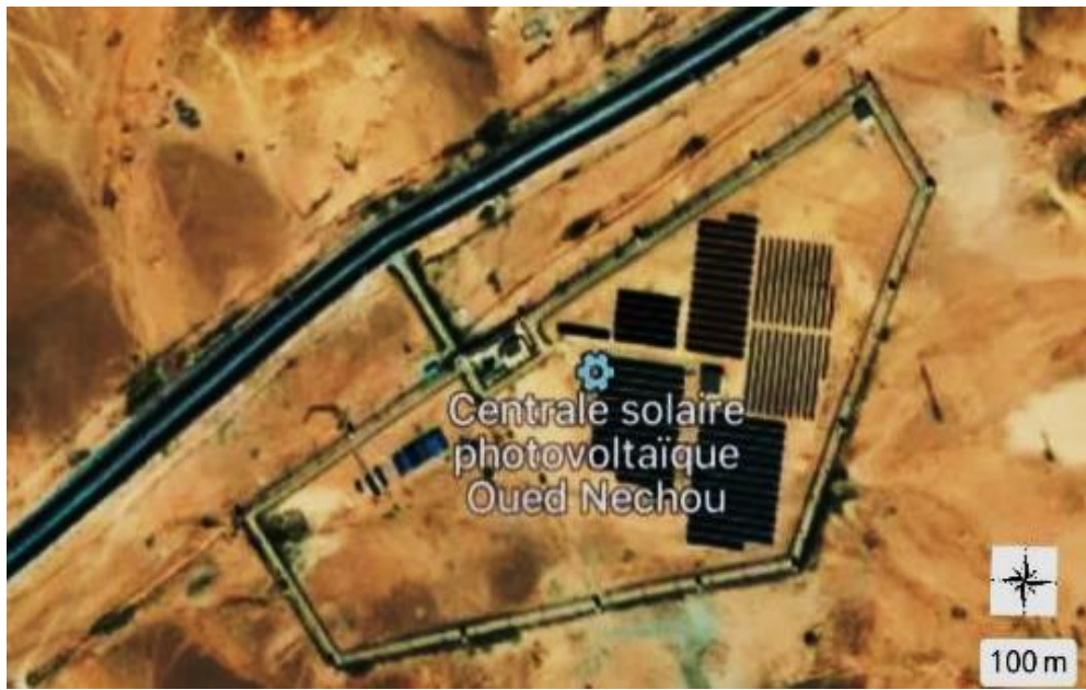
Figure I.26: Localisation géographique du centrale « Ghardaïa- Oued Nechou »
