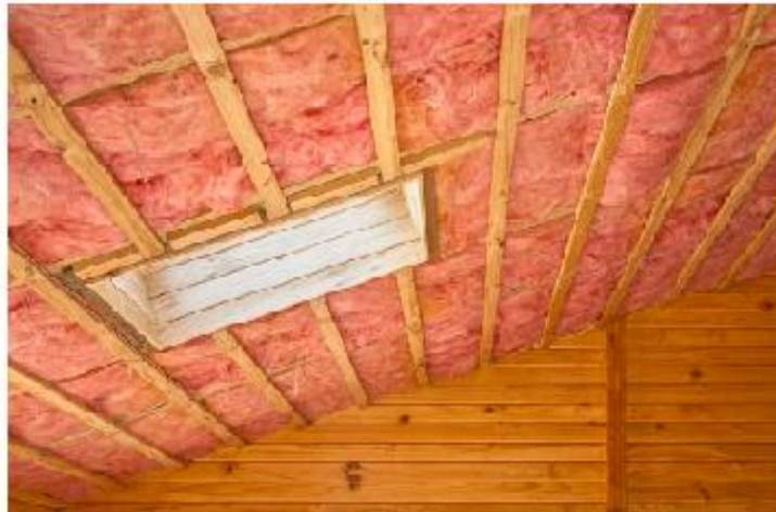
Figure 2.2 : L'isolation par l'intérieur [40].
