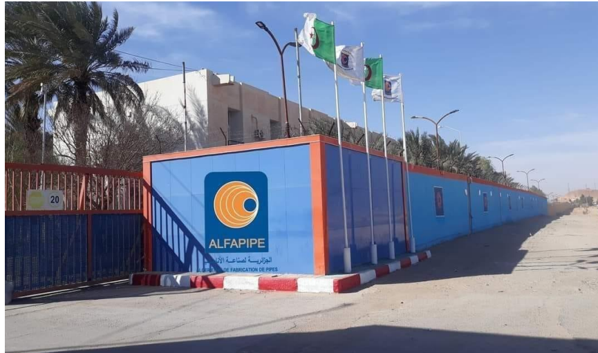
Fig. I.3: La Société ALFAPIPE Ghardaia.
