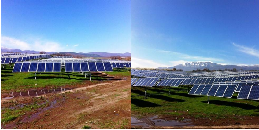
الشكل (4.III): جهاز تعقب Suntrix أفقي أحادي المحور (STH) في اليونان
