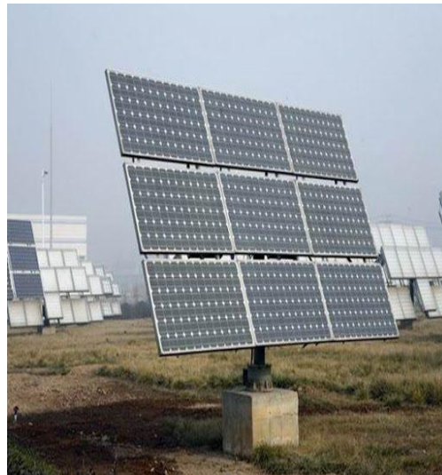
الشكل (5.II): متبعت شمسي ذو محور عمودي
