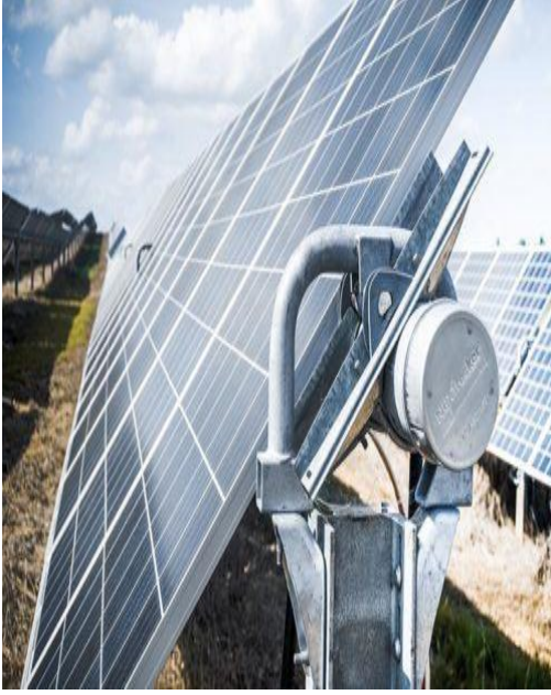
الشكل (4.II): متبعت شمسي ذو محور أفقي
