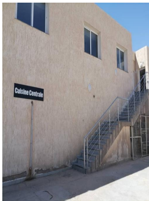
Figure 6 : Cuisine centrale de l'extérieur (Photo originale).
