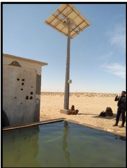
**Photo N°08 : forage équipé de l’énergie solaire**
