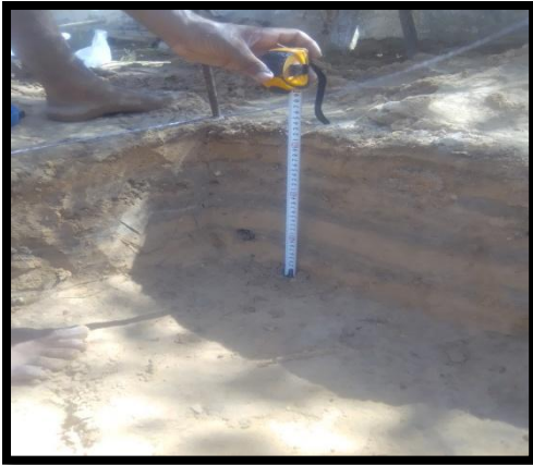
Photo 8: Décapage du sol au niveau de la station WWG Témacine.
