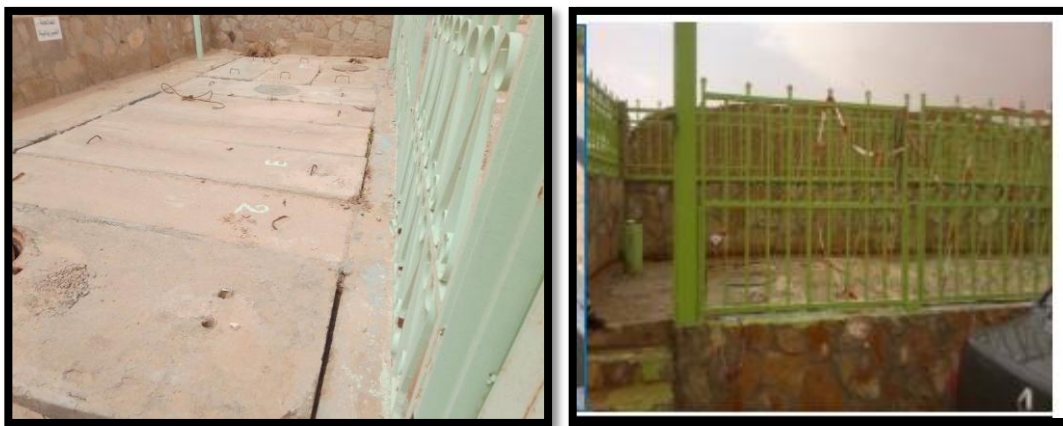
Photo 2: Vue générale de la fosse septique
