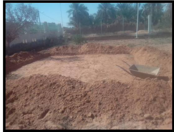
Photo 8: Décapage du sol au niveau de la station WWG Témacine.
