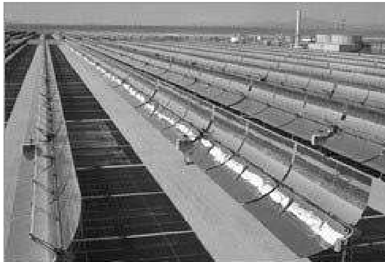
Fig.1.10: La centrale électrique hybride de Hassi Rmel (El Gharbi et al., 2011)
