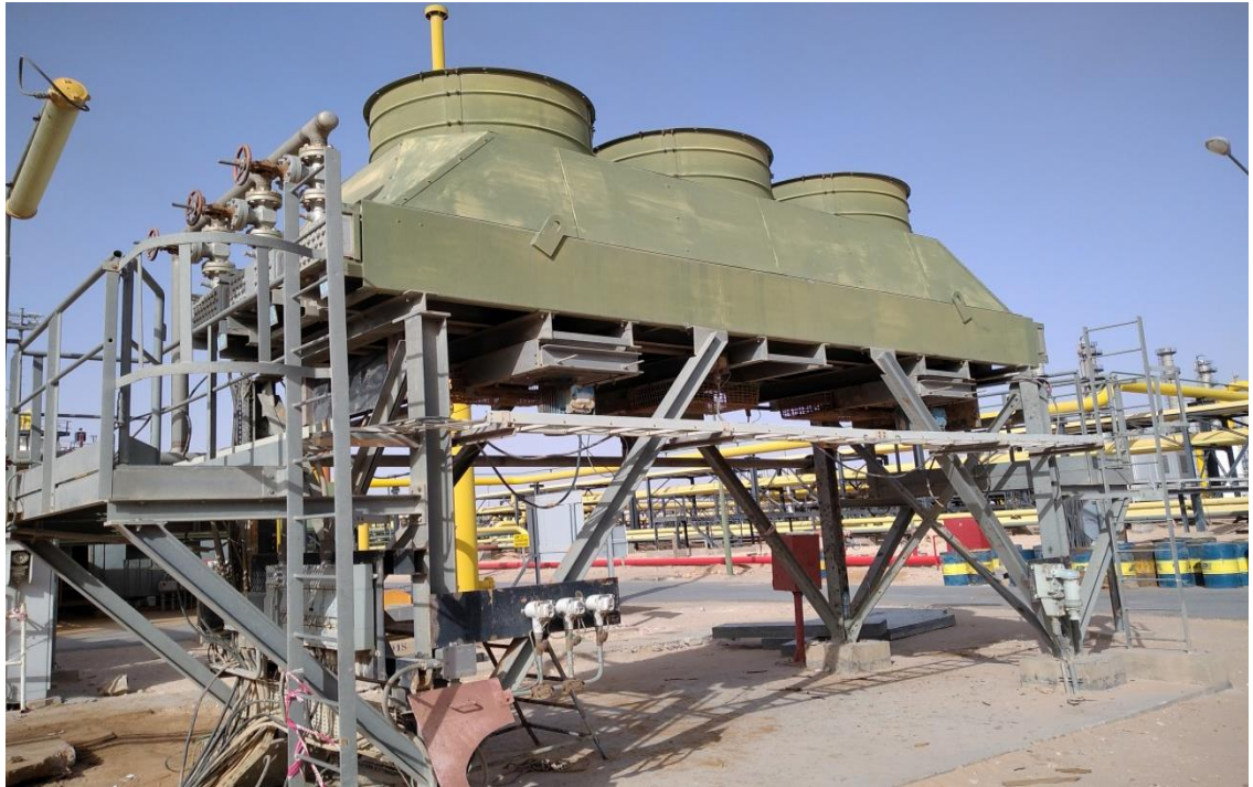
Figure 1-13 : Aéroréfrigérants d'huile .
