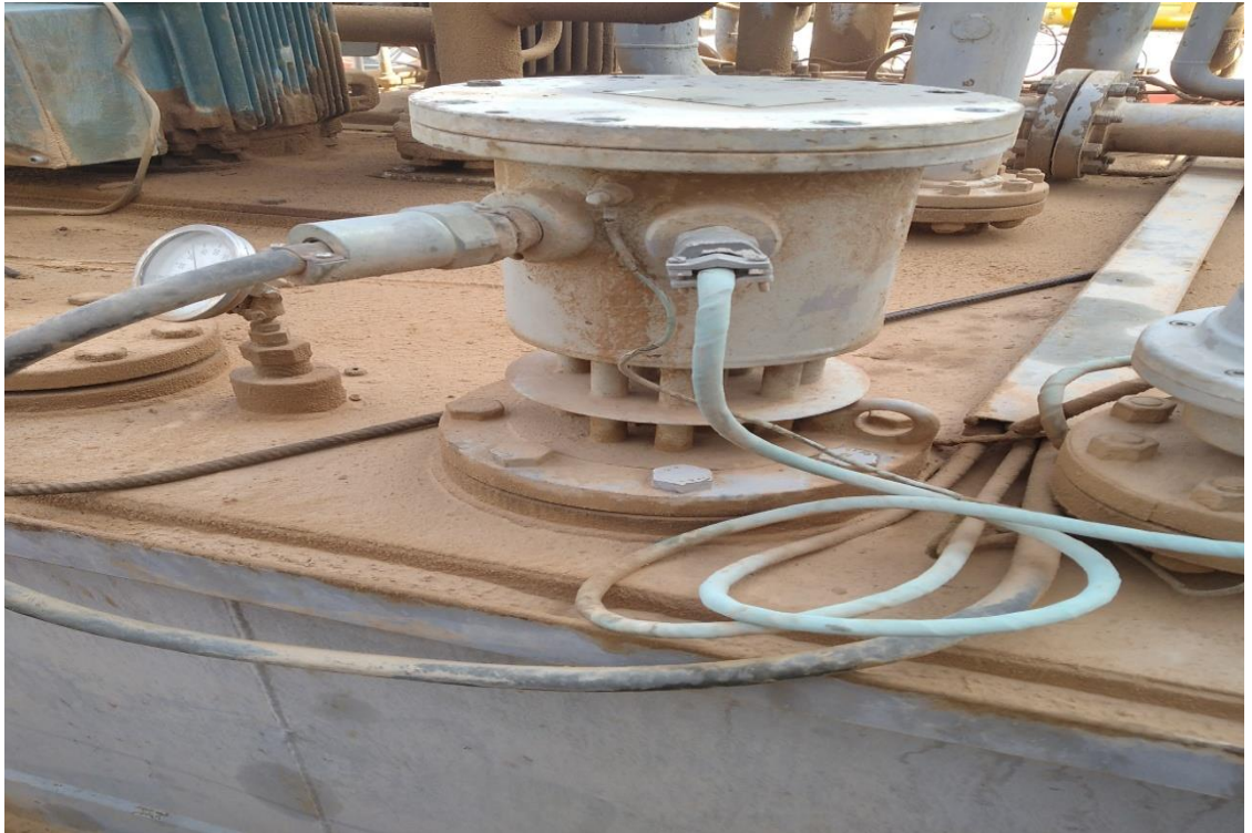
Figure 1-17 : chauffage d'huile.
