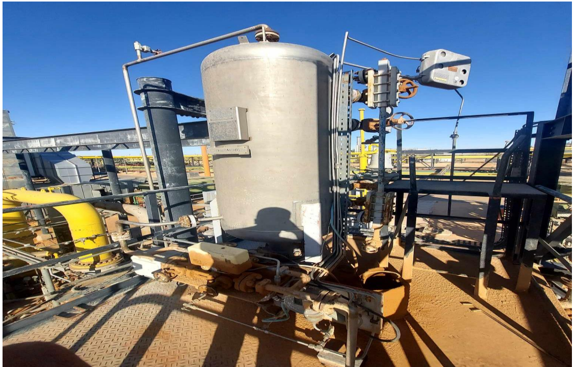
Figure 1-15 : ballon d'étanchéité .
