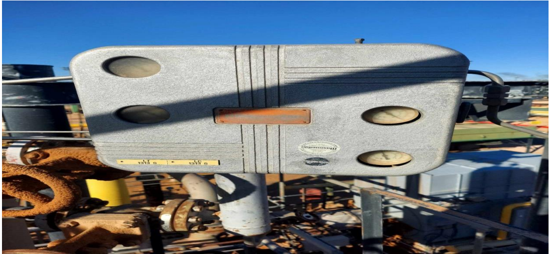
Figure 1-20 : Transmetteur-régulateur de niveau d'étanchéité.
