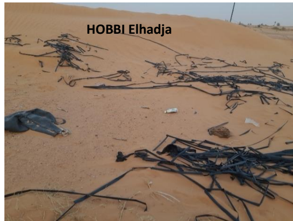
Photo 9. Destruction des infrastructures réseaux d'irrigation à DUBI-DUBI
