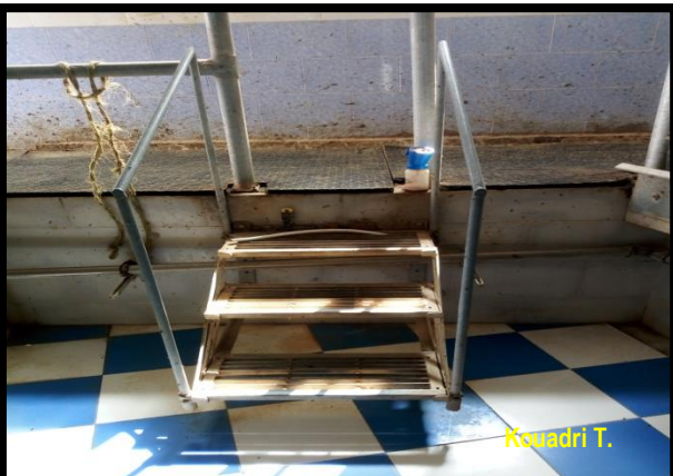
Photo N° 15: escalier en fond de fosse au niveau de la ferme ben hadide
