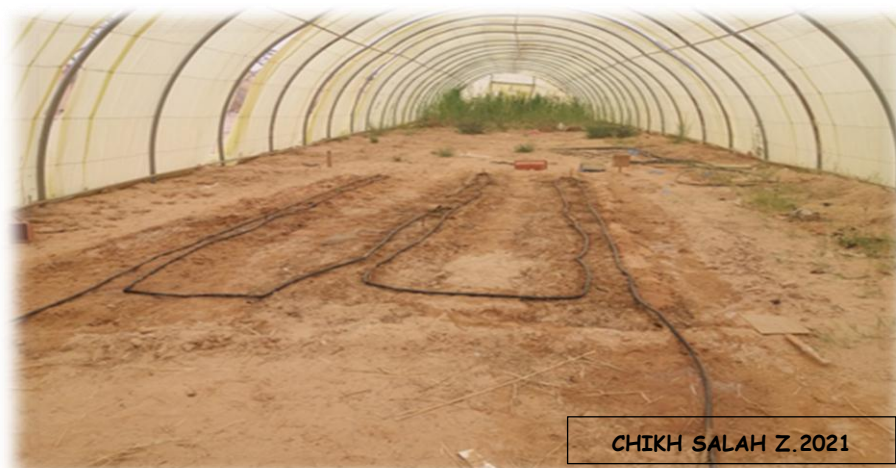
Photo 8 : Installation de système d'irrigation
