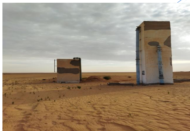
Photo 14 : Diminution du débit d'eau du forage
