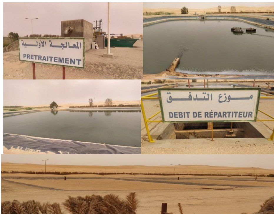
Figure 8 : les étapes de traitement à la STEP DE Sidi khouiled (Originale, 2022)
