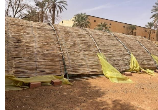
الصورة رقم 09: مبنى المنحل
