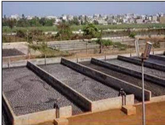
*Figure 6: Boues sèches sur lits de séchage*
