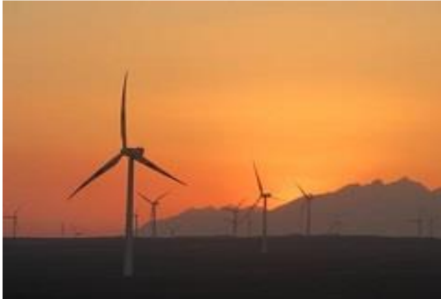
الشكل (1-4) : إحدى محطات توليد الكهرباء من الرياح
