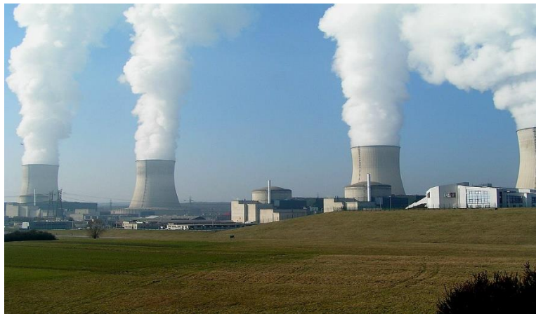
الشكل (1-1) : محطة طاقة نووية (محطة كاتينوم) وانبعث بخار الماء من التوربينات البخارية
