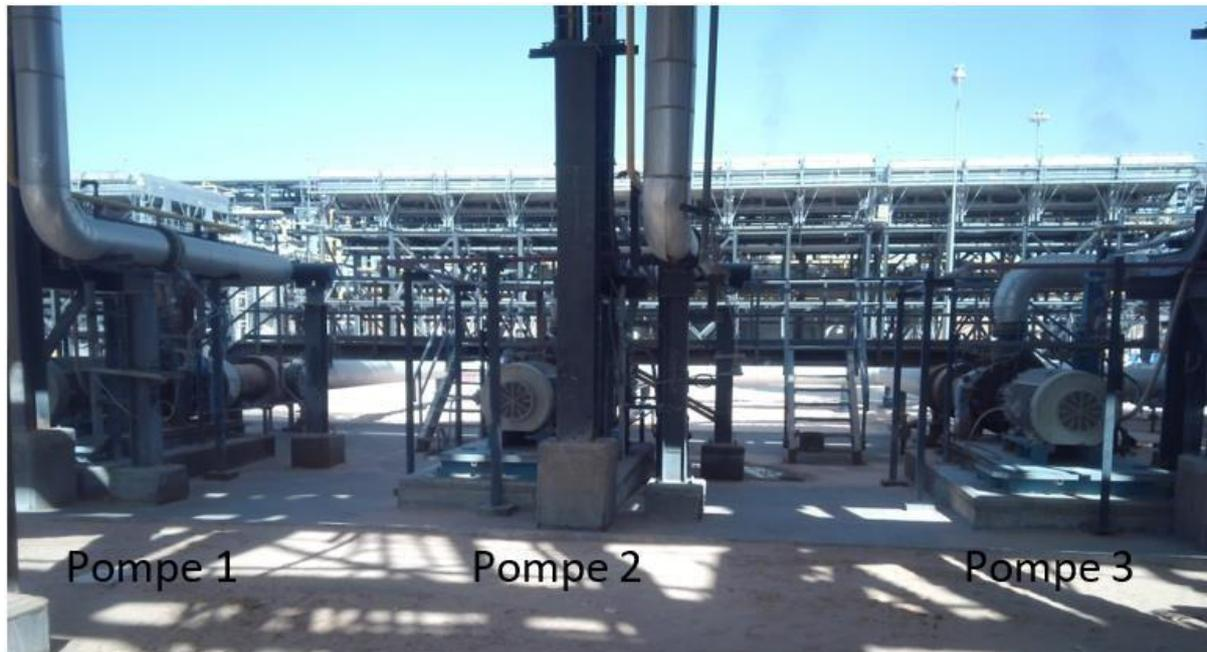
Figure 2.9. Pompes de la colonne de stabilisation
