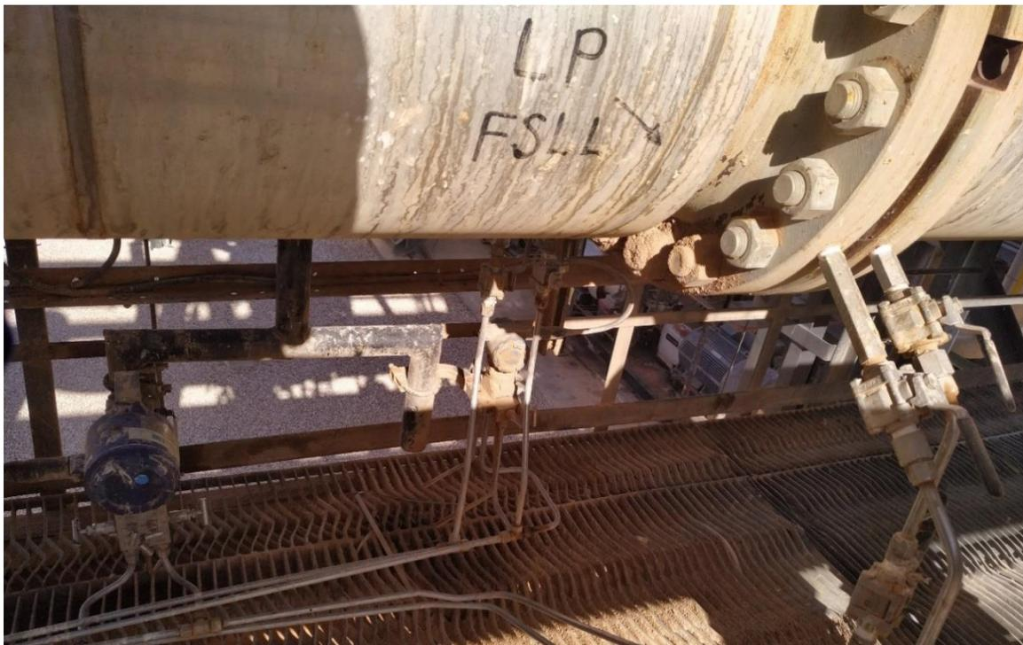
*Figure 2.1. Les instruments de mesure de débit*
