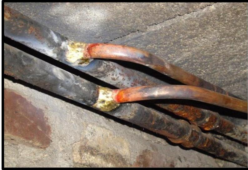
Fig. I.12. Corrosion chimique : Cuivre et acier noir dans une installation
