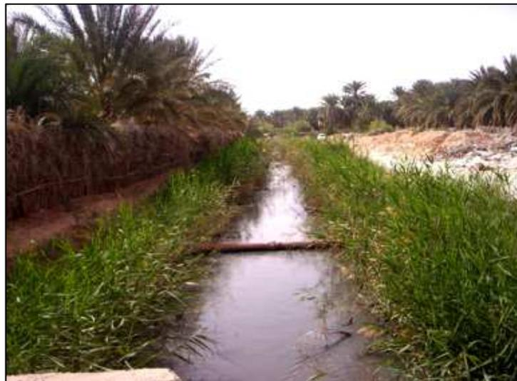
Figure 60. Drain horizontale à ciel ouvert traverse les oasis de palmeraies (Photo Slimani. R, 2006)
