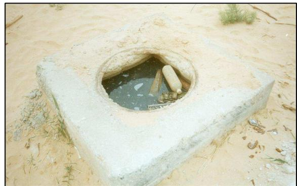
Figure 65. Regard sans tampons obturés par les eaux usées et le sable et le Débordement près de la SR Mekhadma.
