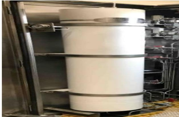
*Figure 1-16: Accumulateur de pression.*
