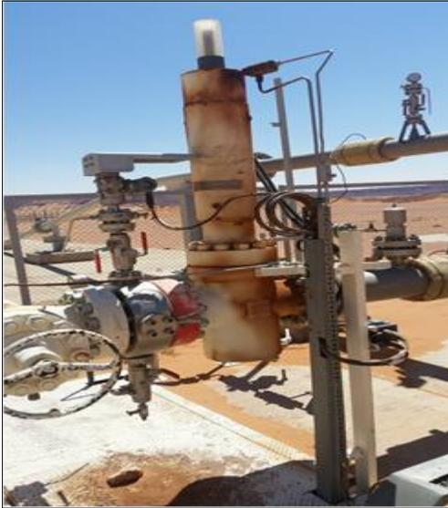
*Figure 1-7 SDV-A à commande hydraulique.*
