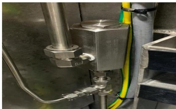
Figure 1-24: soupape de sécurité.
