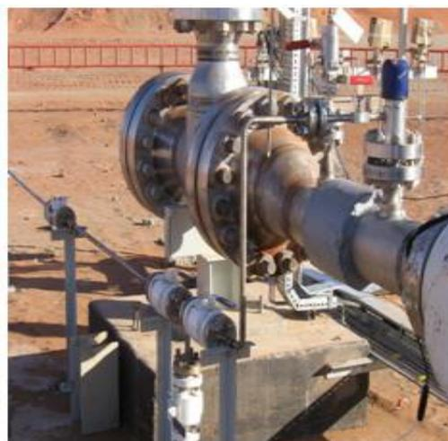
**point d'injection dans le tete de puits**
