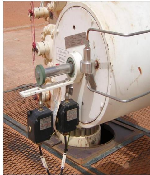
*Figure 1-8 la SDV-A commande à gaz.*
