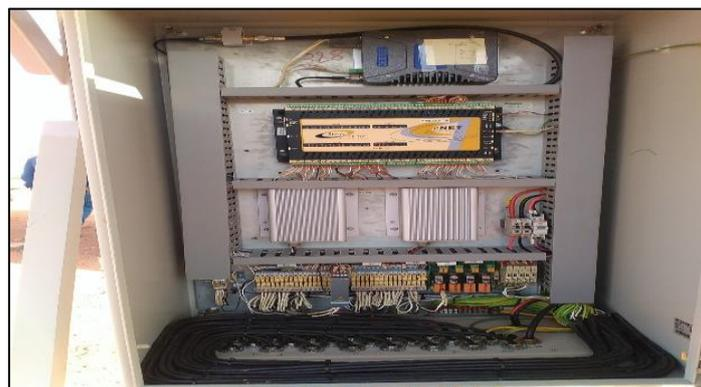
Figure 20-3: L'unité terminale distance RTU.
