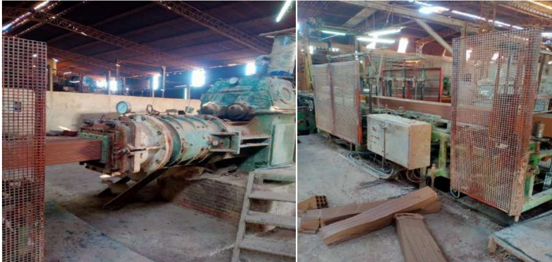
Figure I.16. Façonnage de brique
