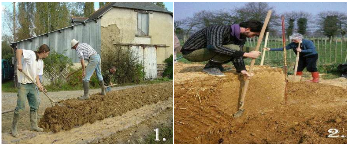
Figure I.11. Construction en Bauge en 1982 à Cesson-Sévigné [15]
