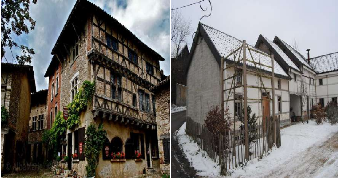
Figure I.10. Bâtiments construit selon la technique du torchis dans le village de Péruges, en France et Havelange, en Belgique
