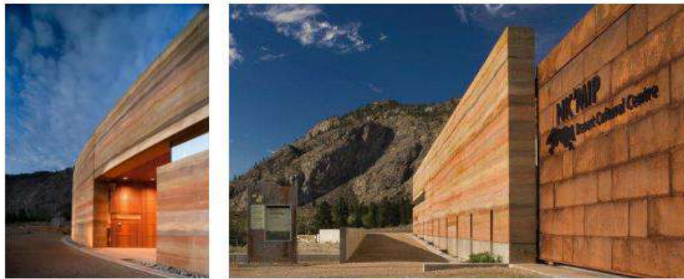
Figure I.5. Centre d'interprétation du désert Nk'Mip, Canada
