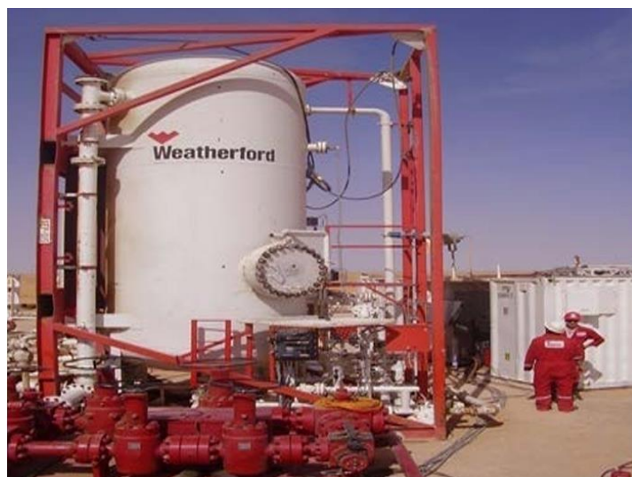
Figure II- 7:Séparateur Vertical sur chantier
