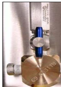
Figure III-11: la soupape d'alimentation du collecteur (Manifold Supply Valve (Open))
